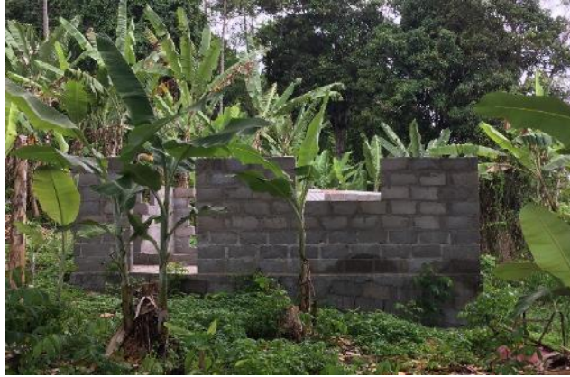
Ilustración 35: Imagen del centro de salud en construcción en Mábana
