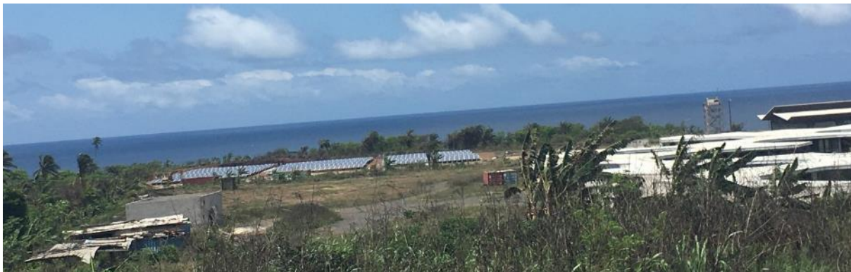
Ilustración 8: Vista de planta fotovoltaica de 1.5 MWp en construcción en la pista del aeropuerto
